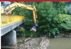
Enlèvement d'embâcle réalisé à WALHEIM en 2011 par le Syndicat Mixte de l'III. Photo: R. LAUGEL CD68
